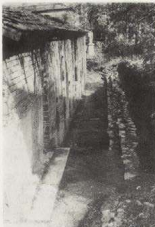
Обр. 1. Разрушената галерия на църквата "Св. Атанас" — поглед от запад
