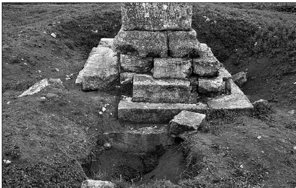
Обр. 29. Основите на стълба от север (снимка К. Чакъров). Fig. 29. The foundations of the pillar from the North (photo K. Chakarov).
