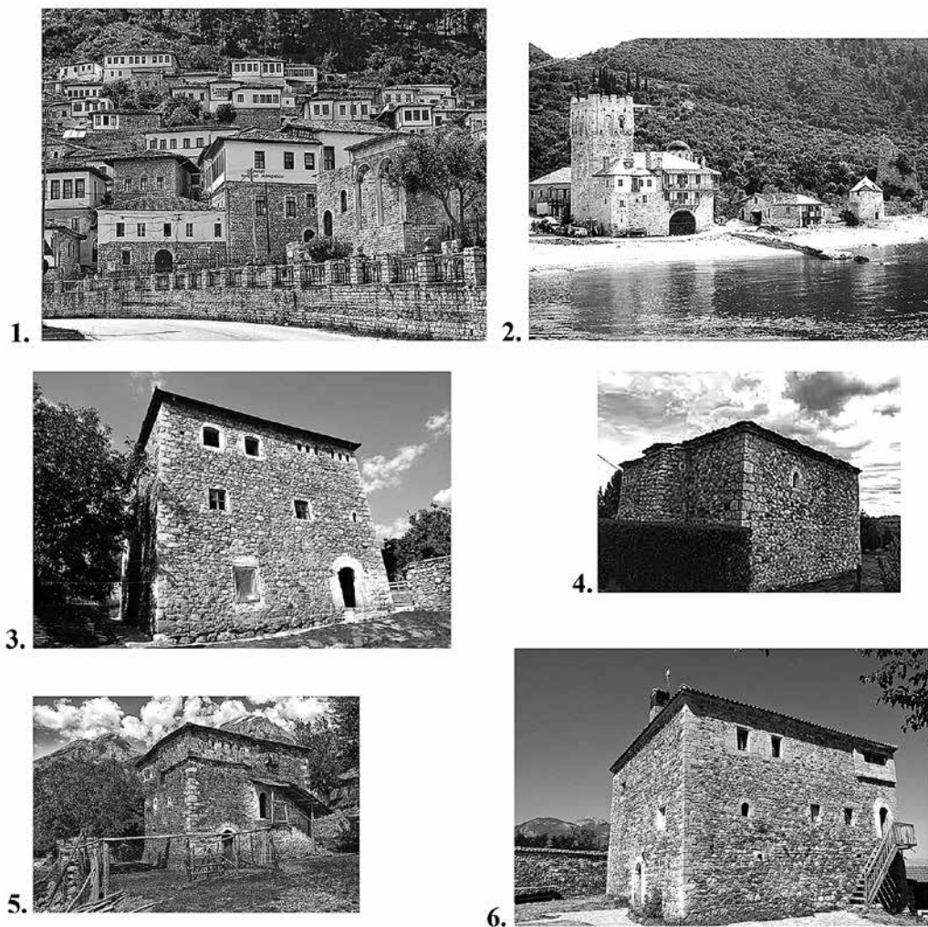
Обр. 1. Сгради от османския период на Балканите.
