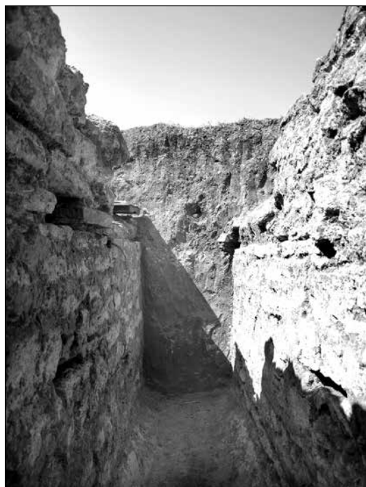
Обр. 7. Сондаж „В“ – каналът с вертикалните страници на шахтата, стъпало и части от свода. Fig. 7. Drilling “B” – the canal with the vertical walls of the shaft, a step and fragments of the arch.
