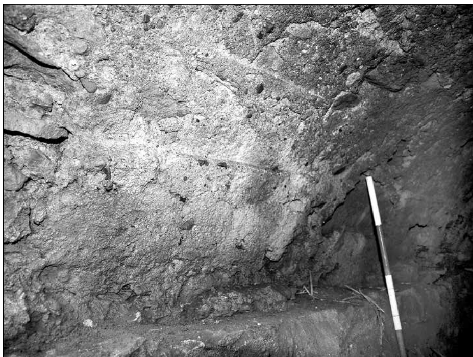
Обр. 4. Сондаж „А“ – отпечатъци от дъските на кофража. Fig. 4. Drilling “A” – foot-prints of the plants in the casing.
