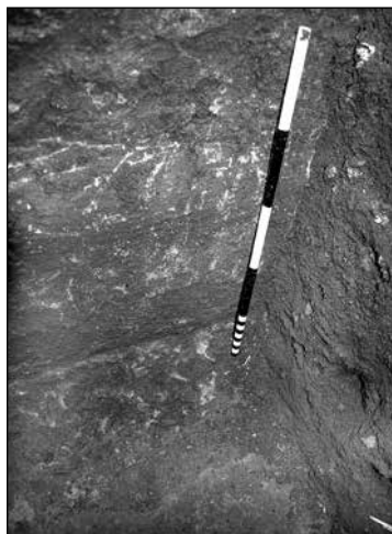
Обр. 3. Сондаж „А“ – обмазка на канал и фуги. Fig. 3. Drilling “A” – coating of the canal and joints.
