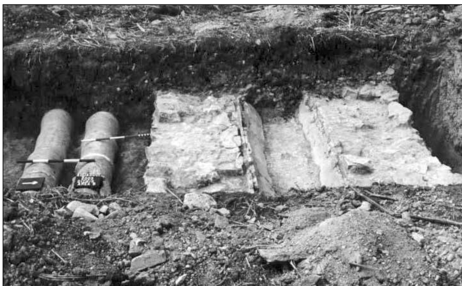
Обр. 6 Каналът на акведукта с дублиращите тръбопровода Fig. 6 The canal of the aqueduct with the duplicate pipelines
