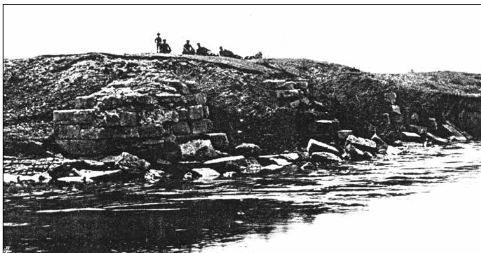
Обр. 5 Останки от кейовете на акведукта (1895 г.) Fig. 5 Remains of the piers of the aqueduct (1895)
