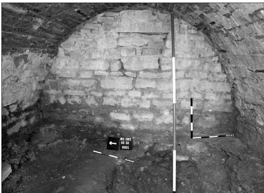
Обр. 10. Castellum aquae – засводена камера със зазидан отвор Fig. 10. Castellum aquae – vaulted cavity with a blind opening
