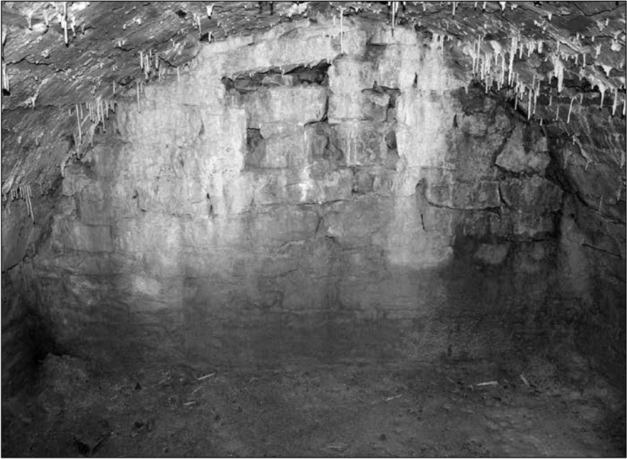
Обр. 11. Castellum aquae – засводена камера от централната група Fig. 11. Castellum aquae – vaulted cavity in the central group
