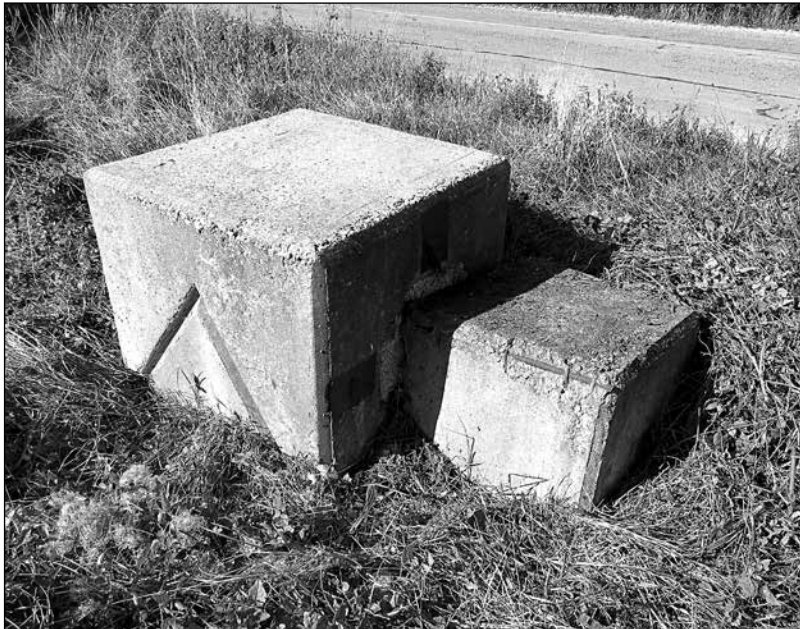
Обр. 6. Паднали и повредени маркировъчни знаци. 6.1. Маркировъчен знак в Шипченския проход. Fig. 6. Fallen and damaged directional signs. 6.1. A directional sign inthe Shipka Pass.
