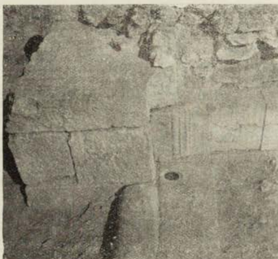
Обр. 9. Гнездото за отвесната ос на външната врата
