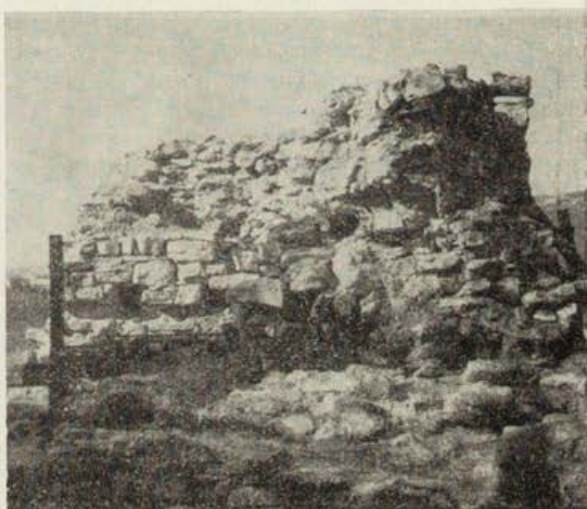
Обр. 10. Северна и западна стена на кулата над Малката порта
