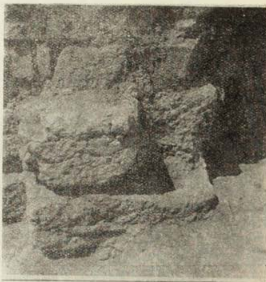
Обр. 11. Гнездото за отвесната ос на вътрешната врата
