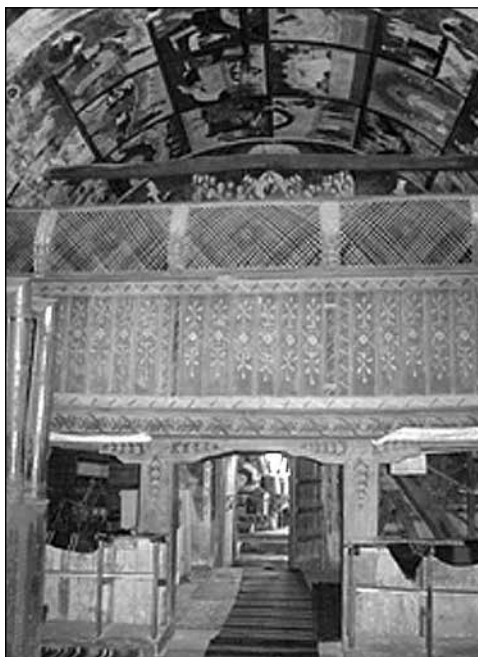
Обр. 3.1. Балкон в западната част на наоса. Fig. 3.1. A balcony in the western part of the naos.
