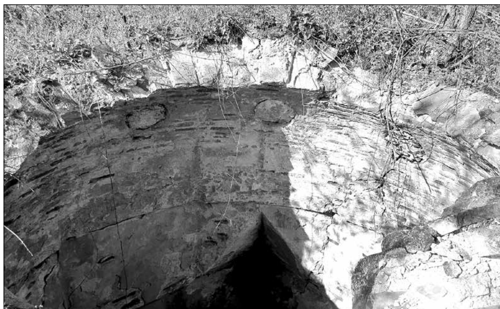
Обр. 4. Дебелина на купола на халвета на Фируз бей хамам във Велико Търново (снимка на автора). Fig. 4. Thickness of the dome above the private corner cell in Firuz Bey Hammam in Veliko Tarnovo (author's picture).
