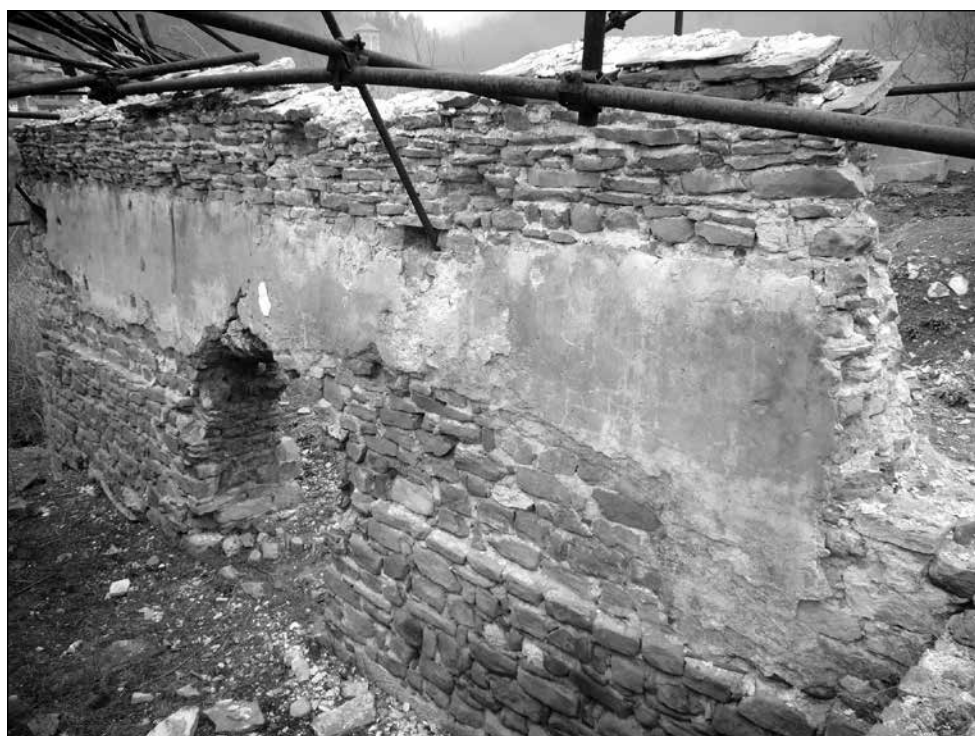
Обр. 11. Помещение № 1 – северна стена с хидрофобна мазилка и аркирания вход Fig. 11. Premises No1 – the northern wall with hydrophobic masonry and arched entrance
