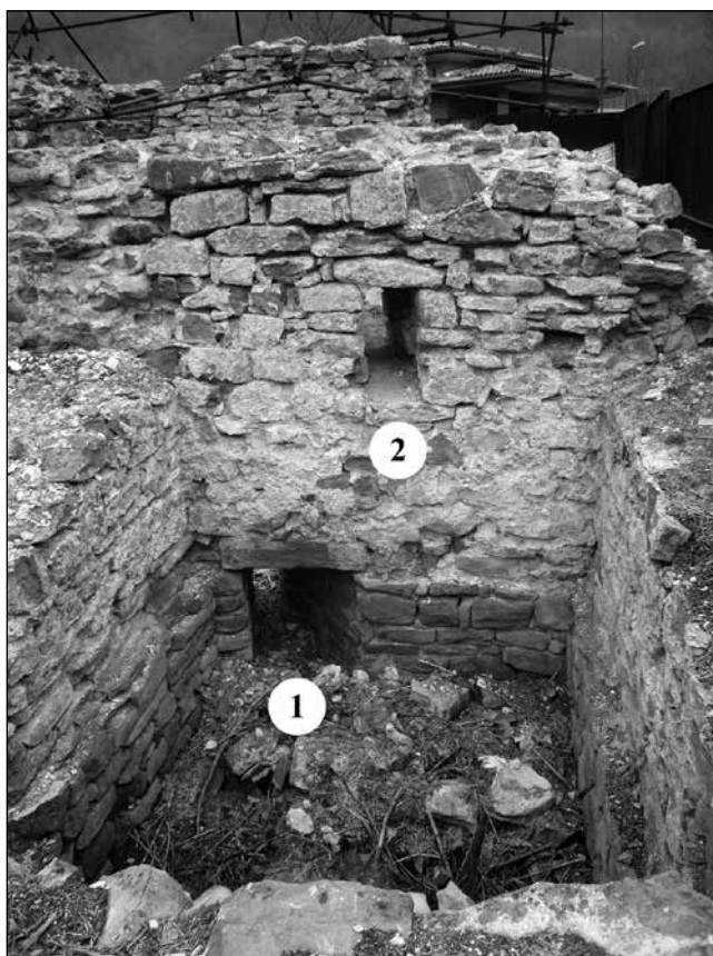
Обр. 22. Помещение № 5 на „Шшиманова“ баня – поглед от юг. 1. Теплопроводящ отвор. 2. Отвор за преминаване на водопроводите от помещение № 3
