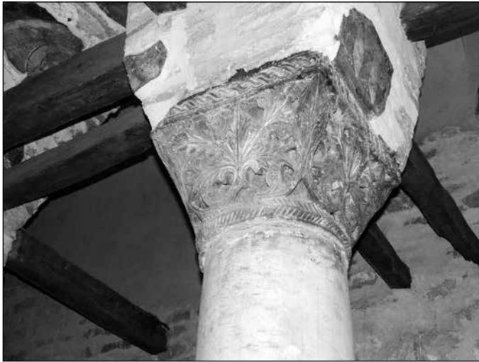
Обр. 11. Кемпферов капител, „ориеантизирац стил“, кат. № 9 – днес от югоизточната колонна конструкция в наоса на църквата
