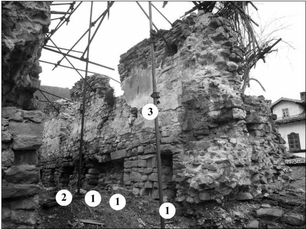
Обр. 12. Помещение № 1 – южна стена с хидрофобна мазилка. 1. Теплопроводящи отвори. 2. Ниша. 3. Отвор за преминаване на водопровода за гореща вода от западния резервоар
