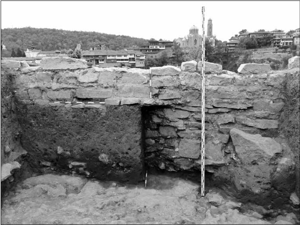
Обр. 6. Изглед отвътре на субструкцията и суперструкцията на крепостната стена в точката на допиране на два строителни стила
