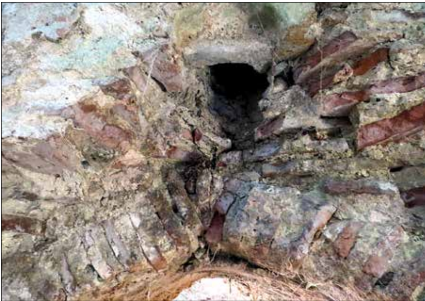
Ил. 2. Отдушник над входа на соуклука на мъжката секция (снимка на автора). Ill. 2. Air vent above the entrance of the soğukluk in the men's department (author's photo).
