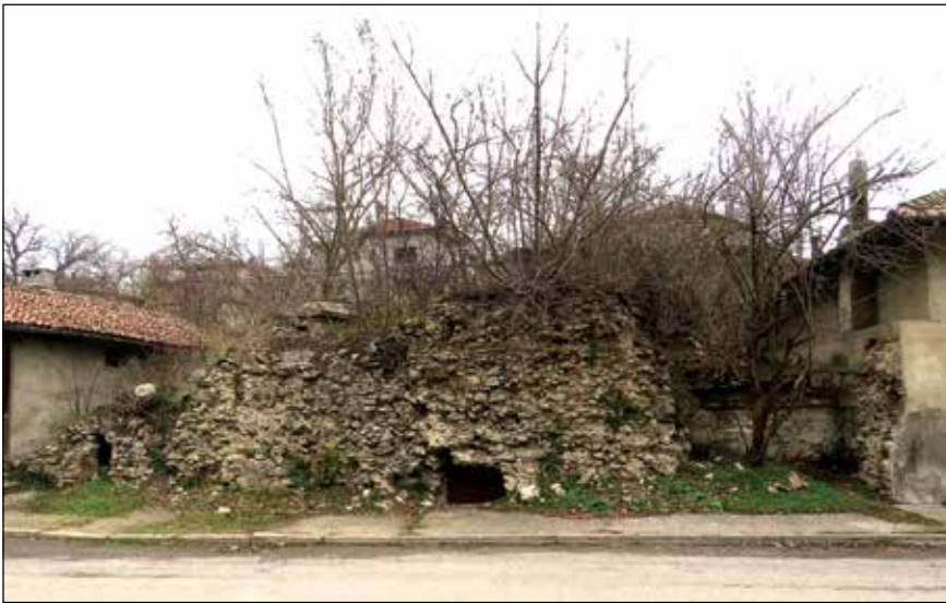
Ил. 1. Чифте хамам във Велико Търново. Съременно състояние (снимка на автора). Ill. 1. Cifte Hammam in Veliko Tarnovo. Contemporary condition (author's photo).
