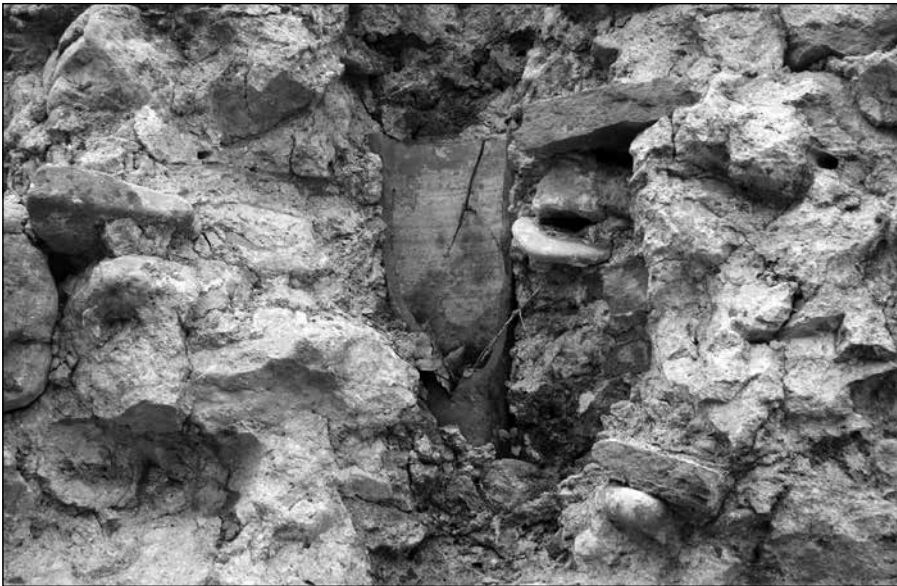
Обр. 13. Вертикални глинени тръби в стените на банята (снимка на автора). Fig. 13. Vertical clay tubes in the bath walls (author's photo).
