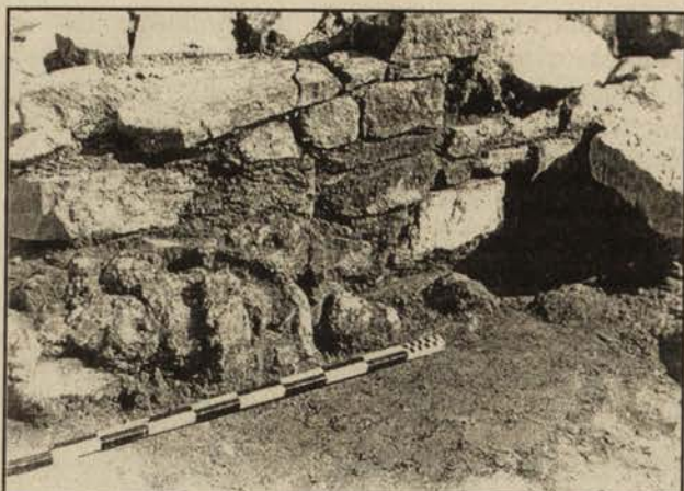
Обр. 5. а) Камък със стенопис в субструкцията на източния зид на притвора на църква №2.
